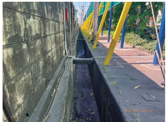
ภาพที่ 24 รางระบายน้ำฝนแยกจากระบบระบายน้ำเสีย
