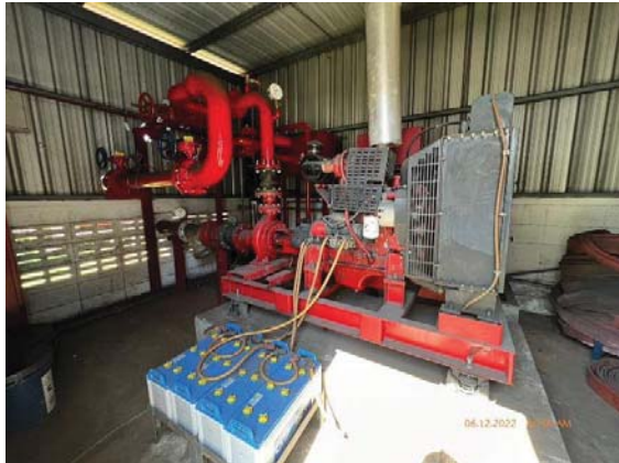
ภาพที่ 61 เครื่องสูบน้ำดับเพลิง
