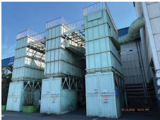
ภาพที่ 9 ปล่องระบบดักฝุ่นจาก Drum Cooler No.2 (Line AMF)
