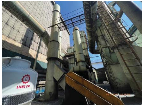
ภาพที่ 4 ปล่องระบบดักฝุ่นจาก Sand preparation (Line ACE)
